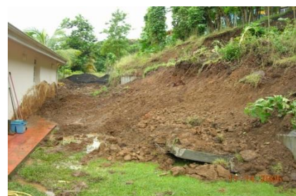
Explosé suite à un éboulement.
