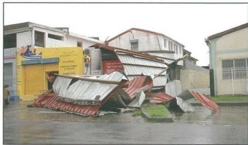
Zone de Laugier : cet amas de tôles cache deux entreprises sinistrées
