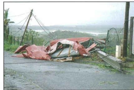
... sa toiture se trouve quelques mètres plus loin !
