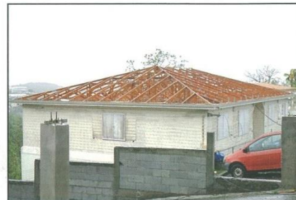
Une charpente dénudée...
