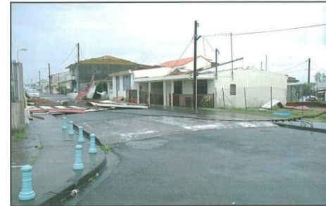
Des maisons du centre-ville endommagées
